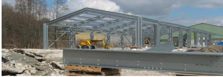
Les profils utilisés par **BATIMENTKIT** sont obtenus par profilage à partir de bobines d'acier à haute limite élastique et galvanisé à chaud, selon le "système Sendzimir".
